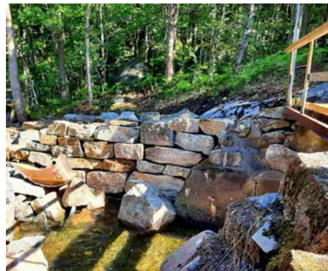
Bygging av fisketrapp ved Sjølingstad Uldvarefabrik.
