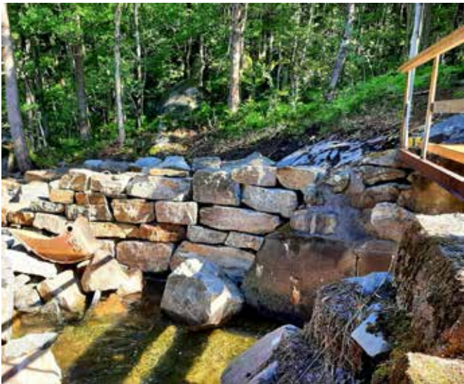
Bygging av fisketrapp ved Sjølingstad Uldvarefabrik.
