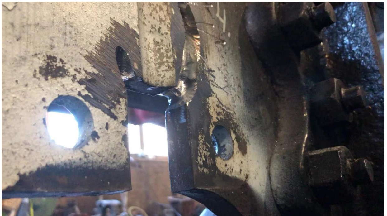
Bilde 6: De første fugene fra den ene siden
