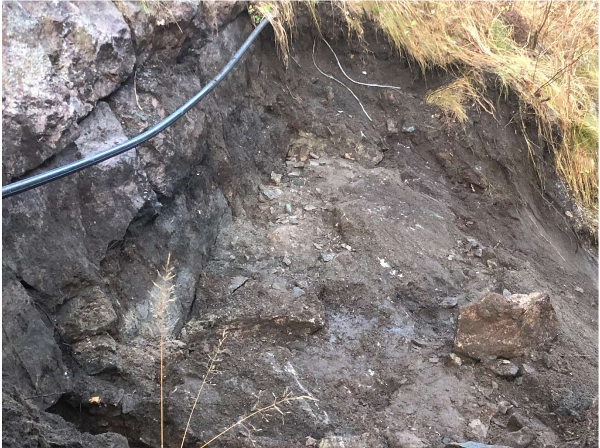
Fjellhulle mellom 0,5 og 1 meter fra mur og ut til skrefjell.
