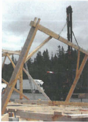
Grind nummer tre heises opp og settes på plass.
