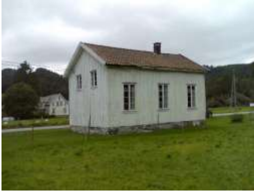
ca.2010, før reparasjon av tak, vegger.
