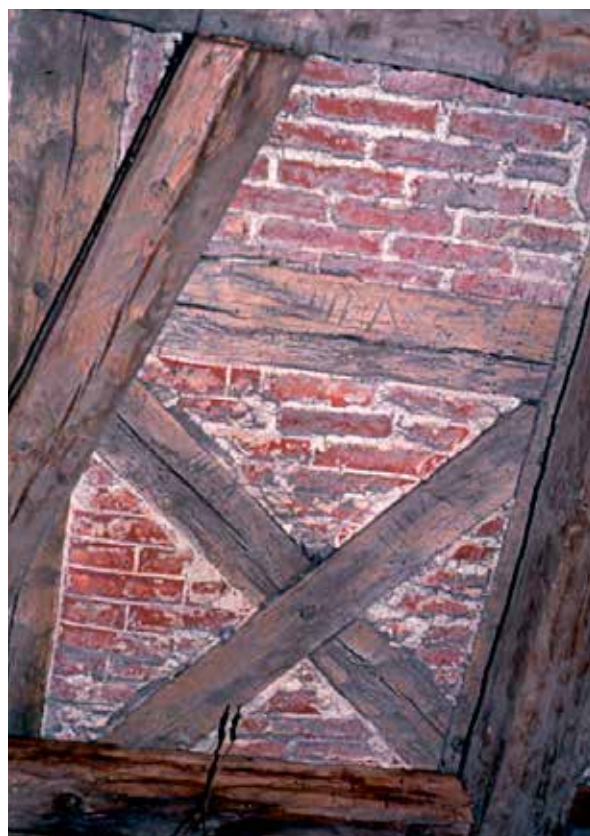
Tømmere og murere hørte til de vanligste håndverkerne i Kristiansands tidlige historie. Her en utmurt bindingsvegg i Oddernes kirkes vestvegg fra slutten av 1600-tallet.
