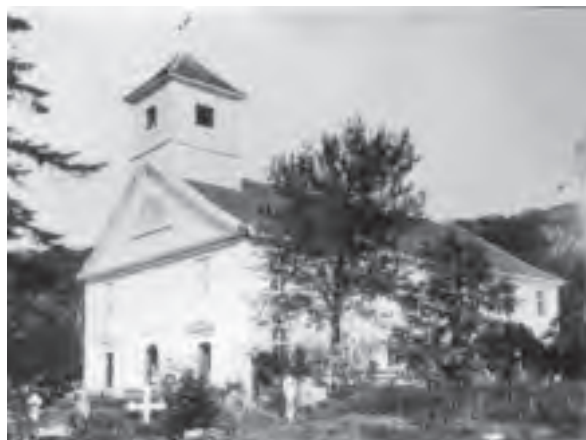
Mandal kirke ble innviet i 1821. Men det gikk mange år før den var helt ferdig. Bildet er tatt like før baldakinen ble bygget over hovedinngangen i 1890. (MK)
