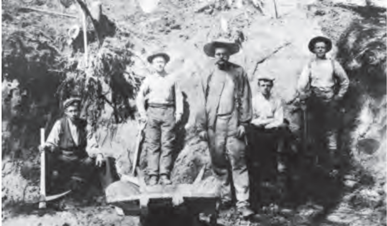
Fem anleggsarbeidere med hakke og spade, trillebåren var et av de viktigste hjelpemidlene rallarne hadde. (Foto Norsk Jernbanemuseum)
