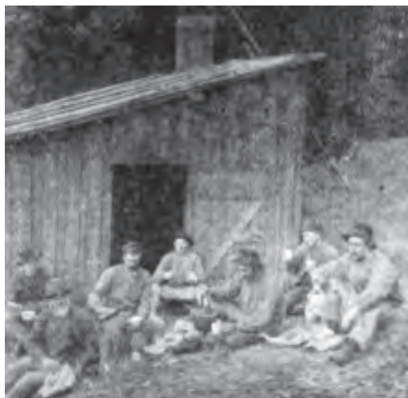
Anleggsarbeiderne levde under enkle forhold. Her inntas frokosten ute i det fri, utenfor anleggsbrakkene. (Fotograf Narve Skarpmoen. Foto Norsk Jernbanemuseum.)
