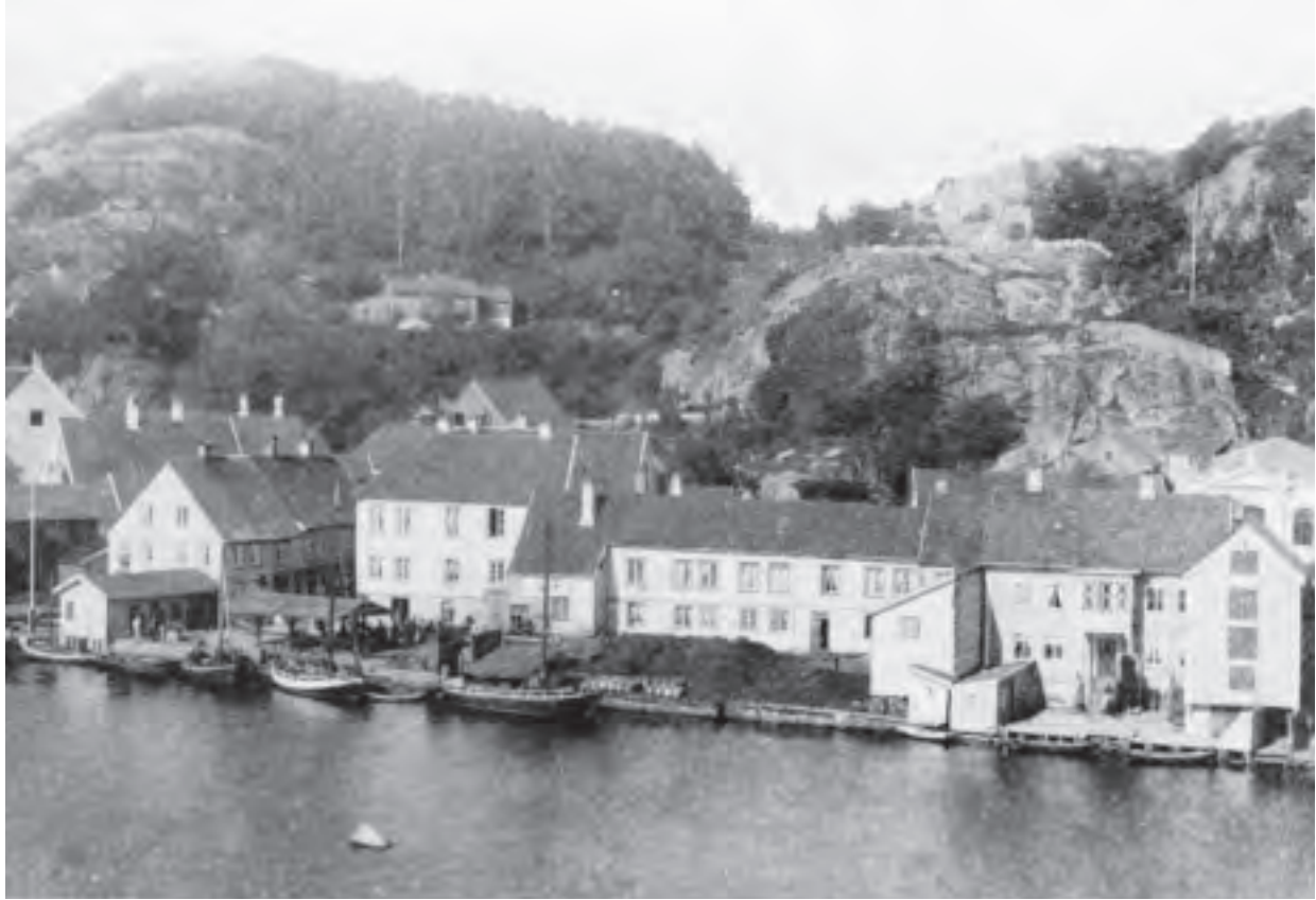
Bebbyggelsen ved Fiskebrygga sett fra Malmø ca. 1890. Det lange huset midt på bildet lå mellom elva og Store Elvegata. Da det ble ervervet av kommunen og revet i 1894, fikk byen ei skikkelig offentlig brygge. Arbeidet ble finansiert med midler fra brennevinssamlagets overskudd. (MK)
