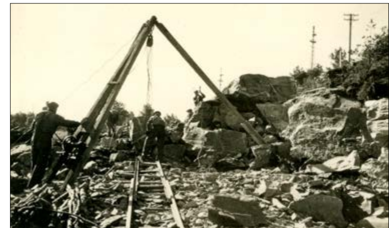
Veibygging på Kroodden i 1941. Stein brytes opp med bor og lofres ved hjelp av bukk over på skinnegående anleggsvogner.
