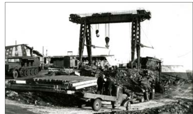
Kanon III nærmer seg slutten av montering. Arbeidet ble utført ved hjelp av traverskranen.
