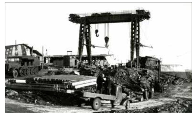
Kanon III nærmer seg slutten av monteringen. Arbeidet ble utført ved hjelp av traverskranen.
