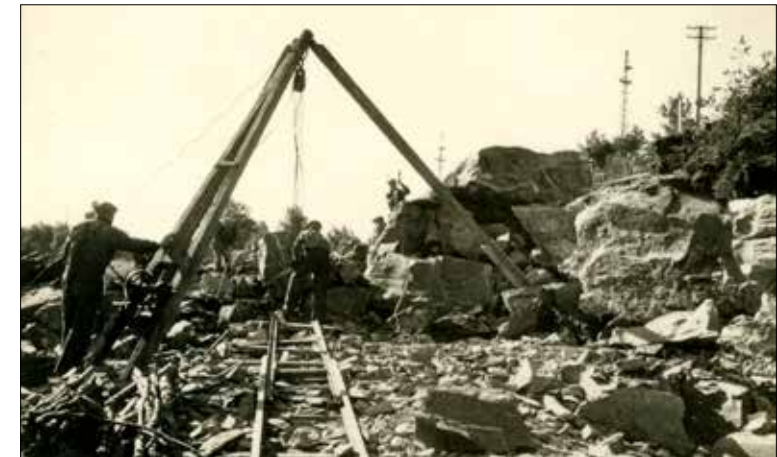
Veibygging på Krodden i 1941. Stein brytes opp med bor og løftes ved hjelp av bukk over på skinnegående anleggsvogner.
