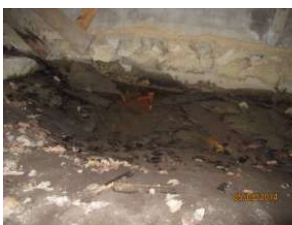
Vann i krypkjeller. NB! Bilde tatt etter langvarig meget stor tørke sommeren 2014
