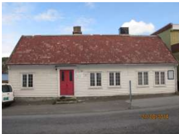
Waages hus (Farsund). Sørveggen
