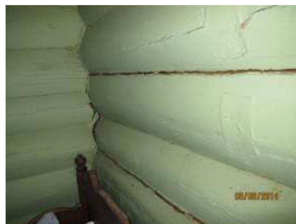
Vegg 1. etasje stue sør
