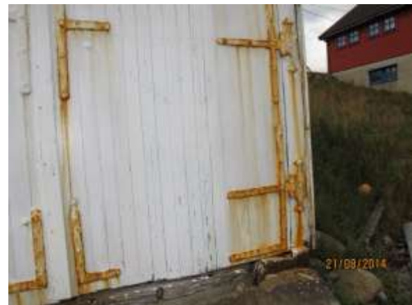
Port rustne hengsler og beslag
