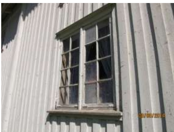
Vindu med plexiglass, restaureres
