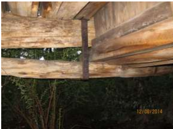
Smidd vinkeljern for å avlaste belastning
