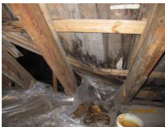
Gammel råteskade i kilrennen
