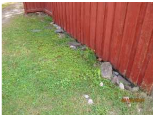
Kledning på nordveggen som går i bakken
