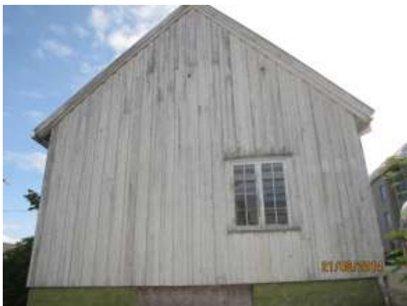
Vestveggen. Kledning skiftes
