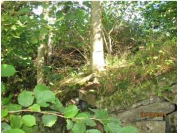
Tre på taket bør tas ned
