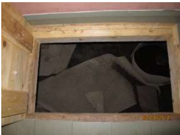
Luke til krypkjeller gang ved kjøkken
