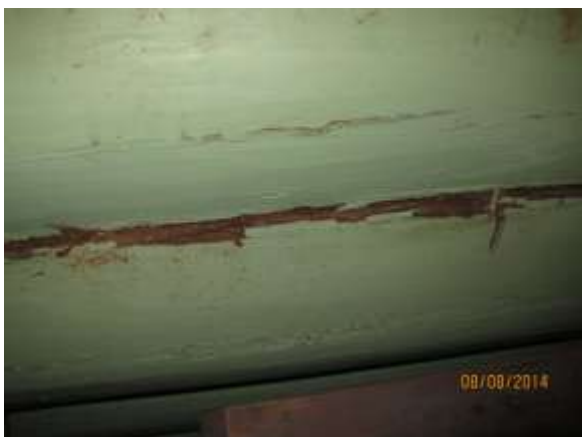
Vegg 1. etasje stue sør
