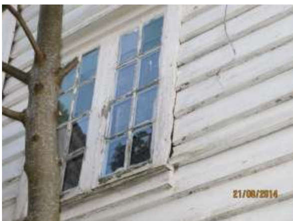
Tre på nordveggen, tas ned
