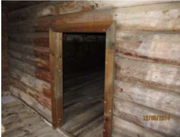
Inngang hovedrom. Tr. impr belistning skiftes
