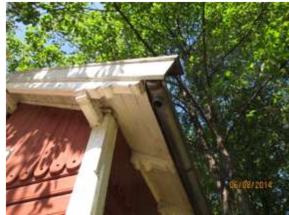
Mangler nedløp/utkast
